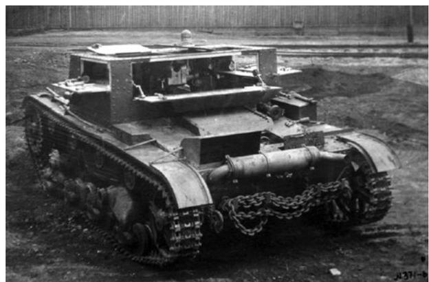
Бронированная рубка САУ АТ-1 имела откидные створки на бортах и сзади, что обеспечивало вентиляцию боевого отделения при стрельбе.
